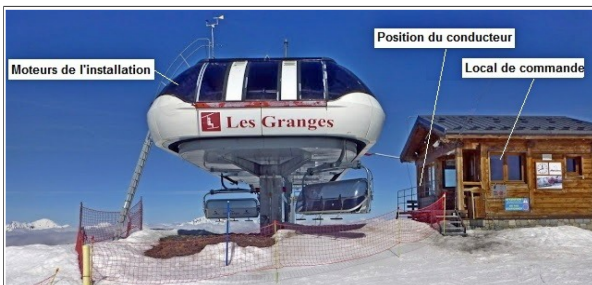
Figure 23 : Position du conducteur en gare haute
