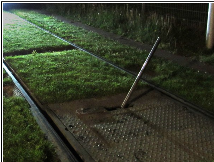
Figure 17 : la manœuvre de l'aiguillage en manuel
