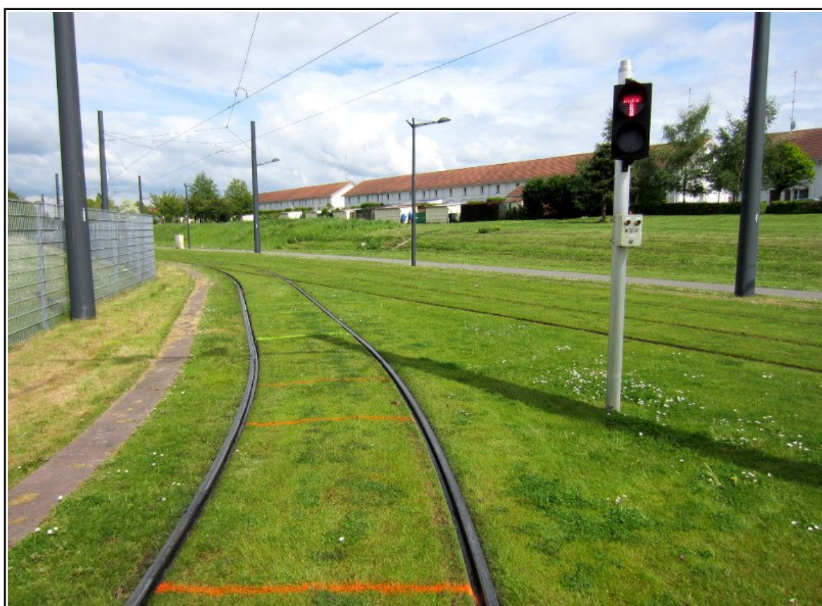
Figure 7 : la sortie du dépôt vue de la voie L1 vers la voie 2. On remarque à droite le signal d'arrêt S30 au rouge.
