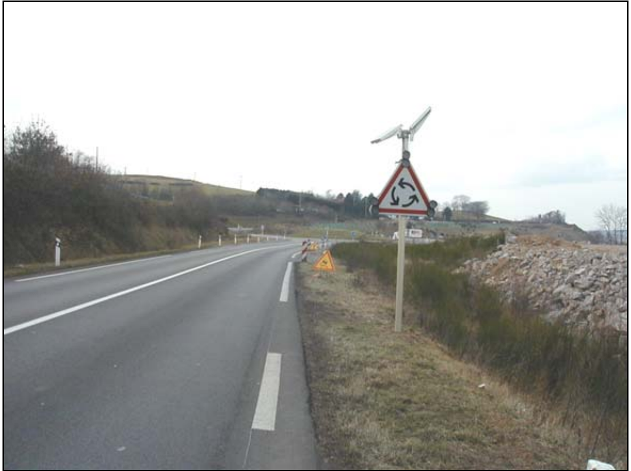
Figure n°7 : Septième vue à 129 mètres de l'entrée du carrefour giratoire.
