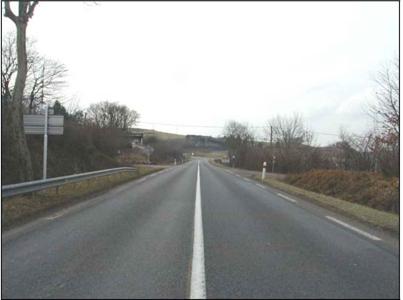
Figure n°5 : Cinquième vue à 286 mètres de l'entrée du carrefour giratoire.
