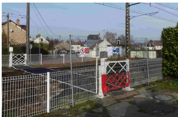
Photo du PN pour piétons d'Héricy après sa fermeture suite à l'accident. Photo BEA-TT
