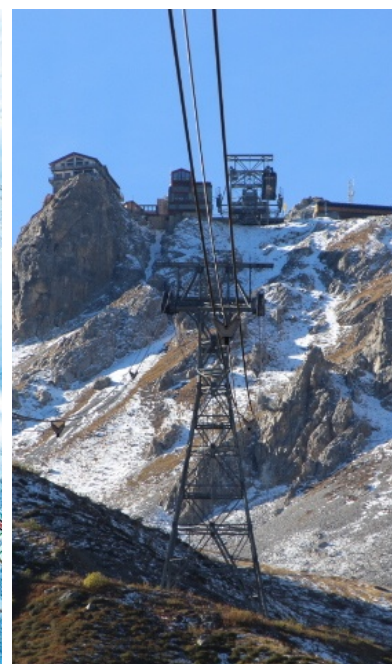
Pylône et gare amont
