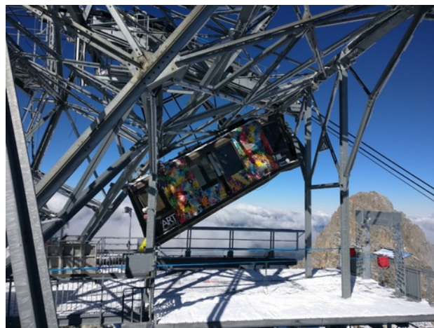
Cabine 2, gare amont
