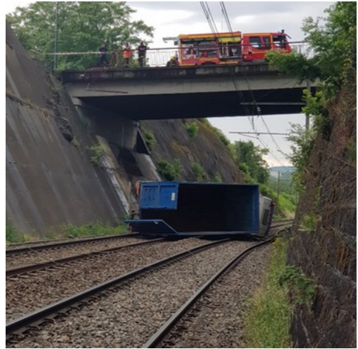
Saint-Chamond (Loire), camion-benne tombé sur les voies, vu depuis la voie
