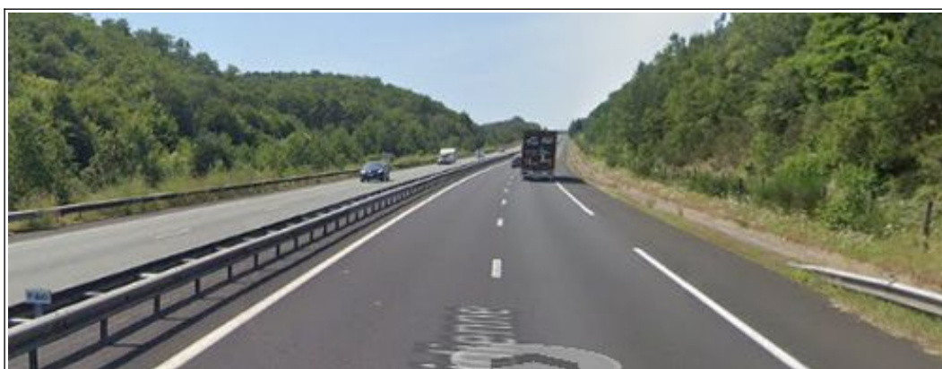
Figure 40 : Vue 300 m environ en amont du lieu de l'accident
