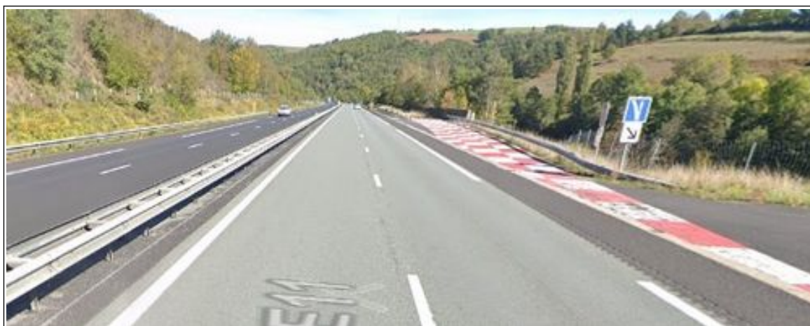
Figure 16 : A75 en sens sud-nord vers le PR 76 +700, voie de détresse pour les véhicules lourds en cas de défaillance du système de freinage (Photo Google Street View, septembre 2021)
