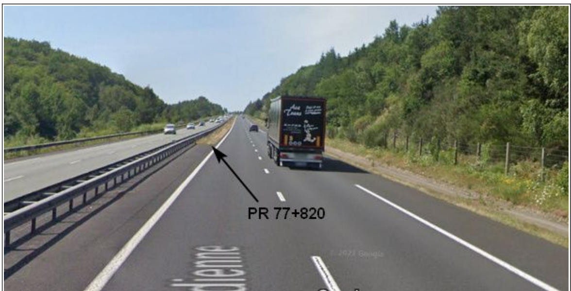
Figure 7 : Vue de la zone de l'accident, une centaine de mètres en amont de la vue précédente (Photo Google Street View, août 2021)
