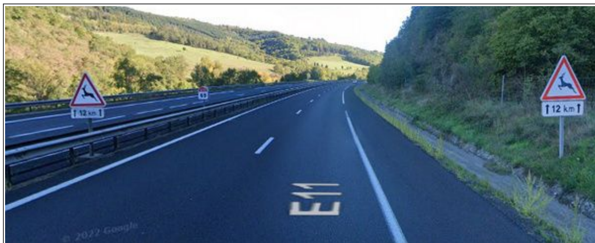
Figure 13 : A75 en sens nord-sud aux environs du PR 69, Panneau A15b associé à un panneau d'étendue (Photo Google Street View, septembre 2021)
