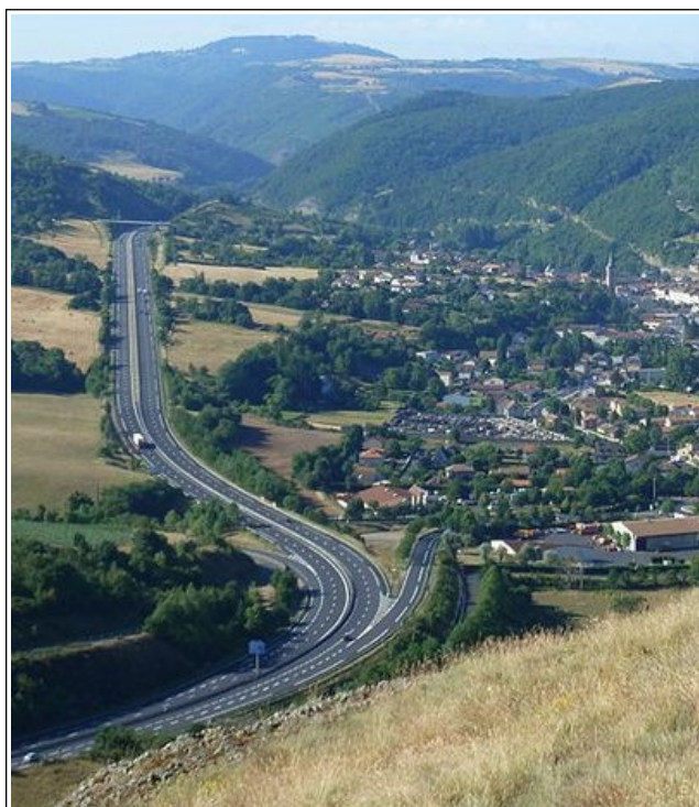
Figure 10 : Vue en direction du sud sur l'A75 à Massiac, avec en premier plan, le diffuseur 23 (Massiac-nord) (source : commonswiki - BDelpeuch)
