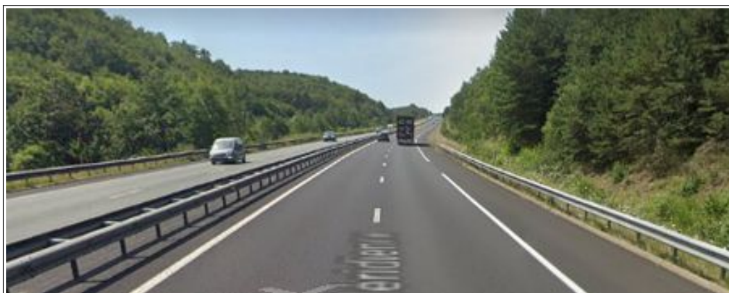
Figure 39 : Vue 400 m environ en amont du lieu de l'accident
