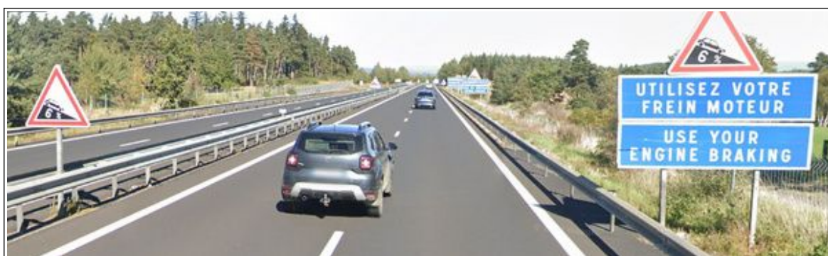
Figure 14 : A75 en sens sud-nord aux environs du PR 80, panneau A16 « descente dangereuse » associé à un panneau de rappel des règles de conduite (Photo Google Street View, septembre 2021)
