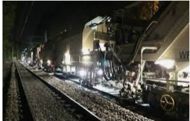
Train de travaux ETF (source ETF)
