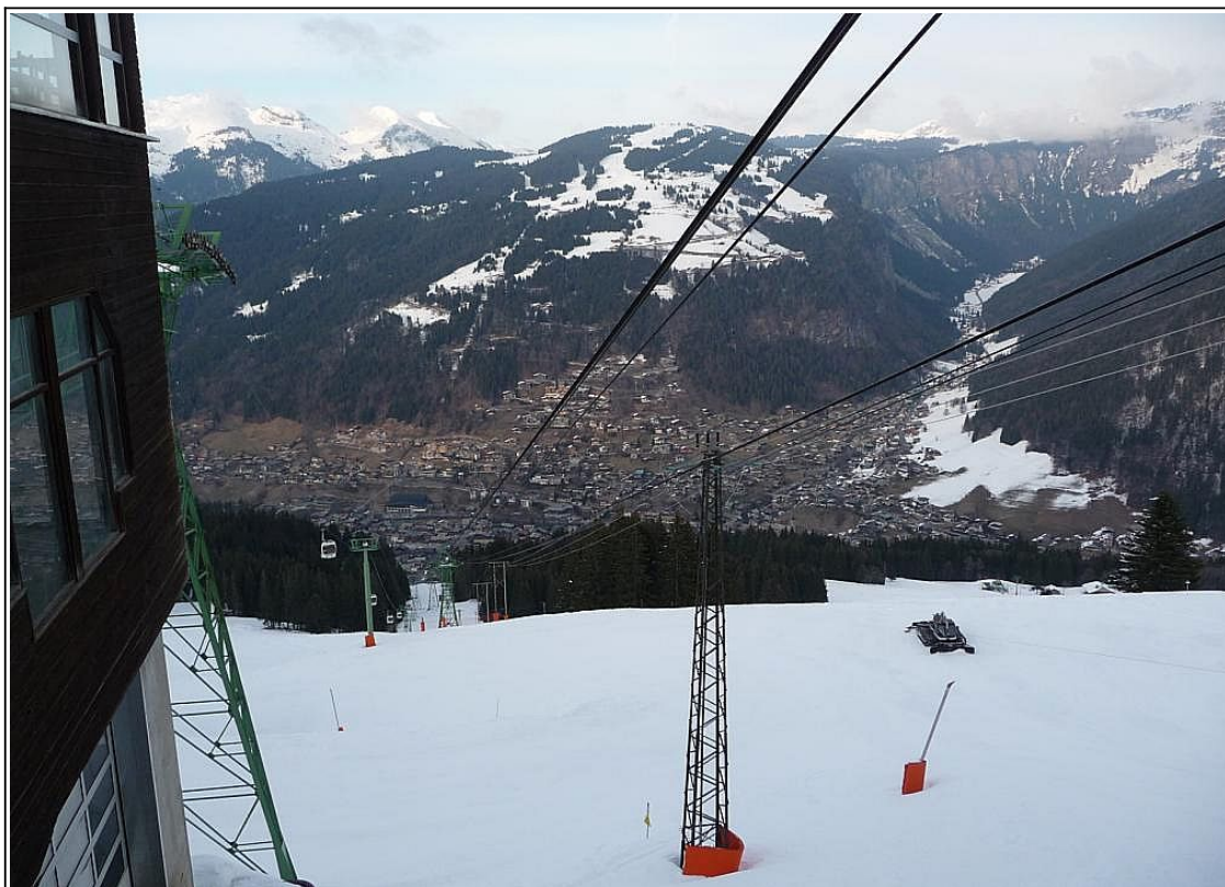
Fig. 3 : Le téléphérique du Pleney vu depuis sa station supérieure
