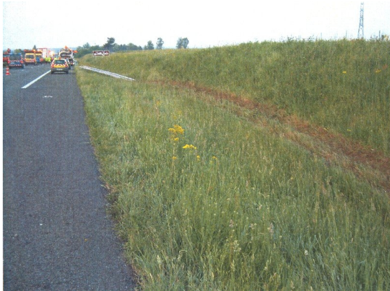
Les traces de roulement de l'ensemble routier (A+A') sur l'accotement, après sortie de route
