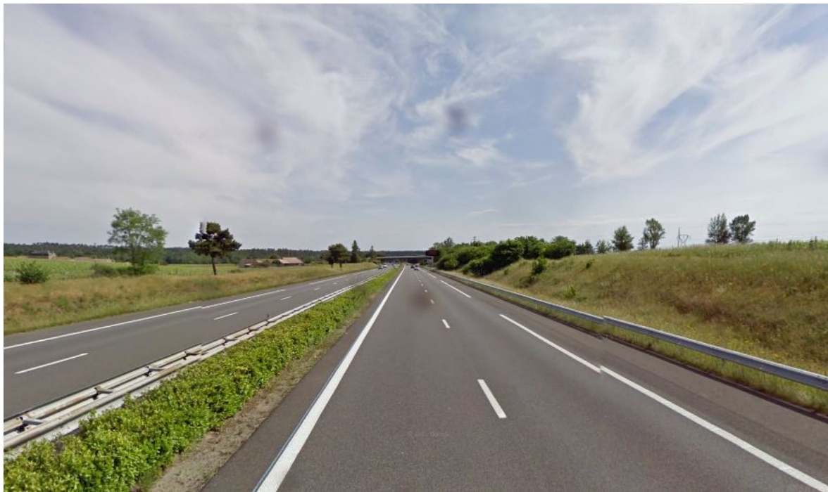
Figure 1 : le PR 494,7 de l'autoroute A10 sens nord-sud, lieu de l'accident
