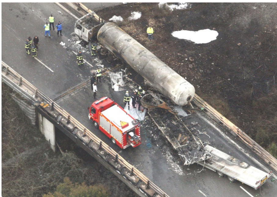
Figure 4 : Vue aérienne rapprochée du lieu de l'accident
