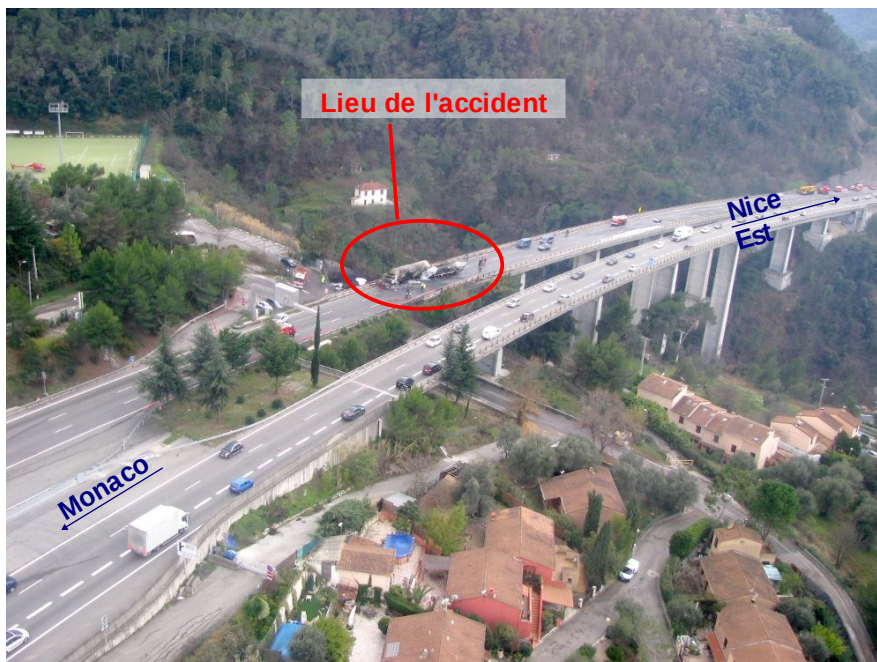
Figure 3 : Vue aérienne générale du lieu de l'accident
