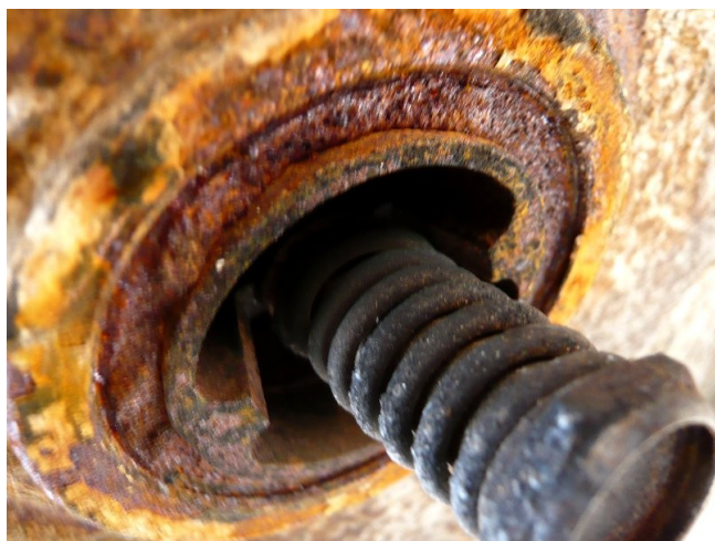
Figure 27 : Vanne de sortie de la phase gazeuse (partie supérieure, avec le ressort apparent de l'obturateur de sécurité)
