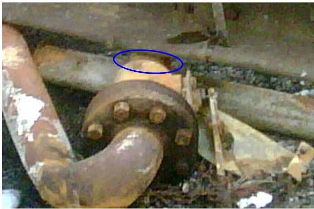
Figure 26 : Vanne de sortie de la phase liquide avec le début du filetage dans le cercle bleu
