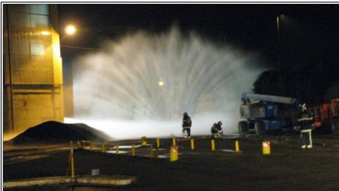
Figure 39 : Exercice de mise en œuvre d'une queue de paon
