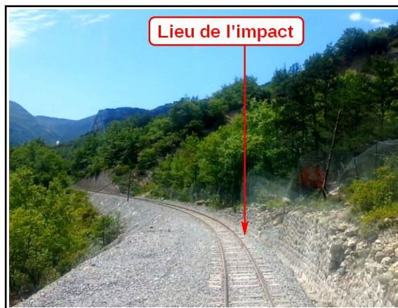
4 - Au niveau du lieu de l'impact au 74+070
