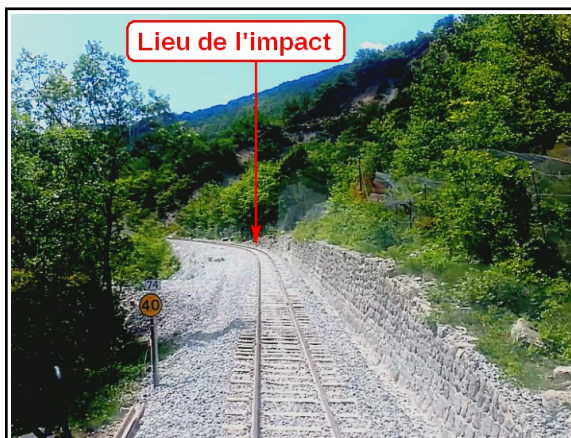
3 - Signal d'exécution à 40 km/h au PK 74+000
