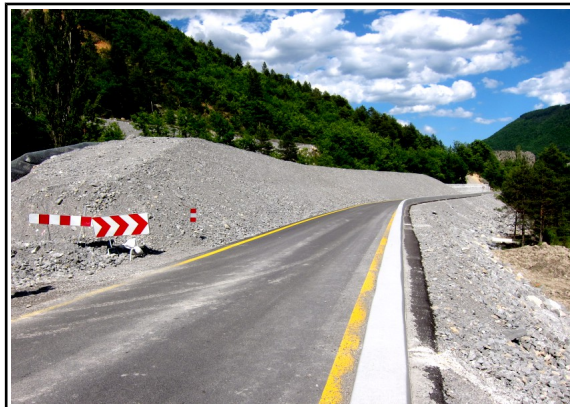
Le merlon de protection le long de la RN 202
