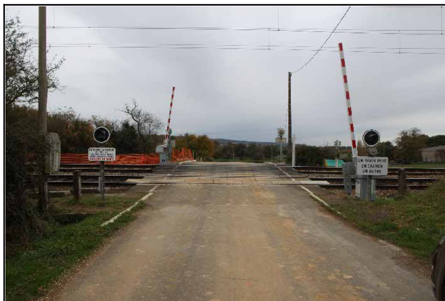
Figure 7 : Vue du passage à niveau n° 128 dans le sens opposé à celui de la circulation de l'ensemble routier accidenté
