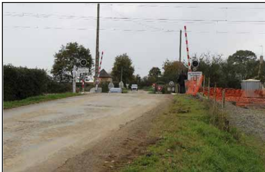
Figure 6 : Vue du passage à niveau n° 128 dans le sens de circulation de l'ensemble routier accidenté
