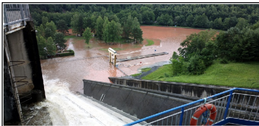
Figure 10 : L'aval du plan incliné inondé
