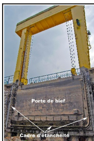
Figure 17 : Porte du bief aval en l'absence du bac
