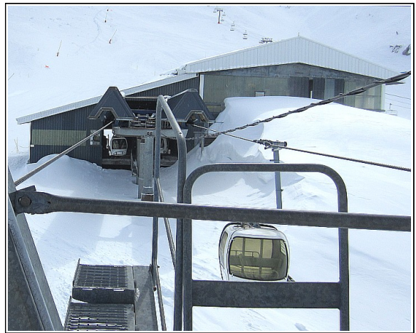
2 - La station supérieure vue depuis le pylône P14
