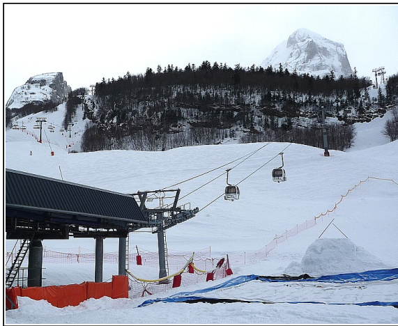
1 - L'installation vue depuis sa station inférieure
