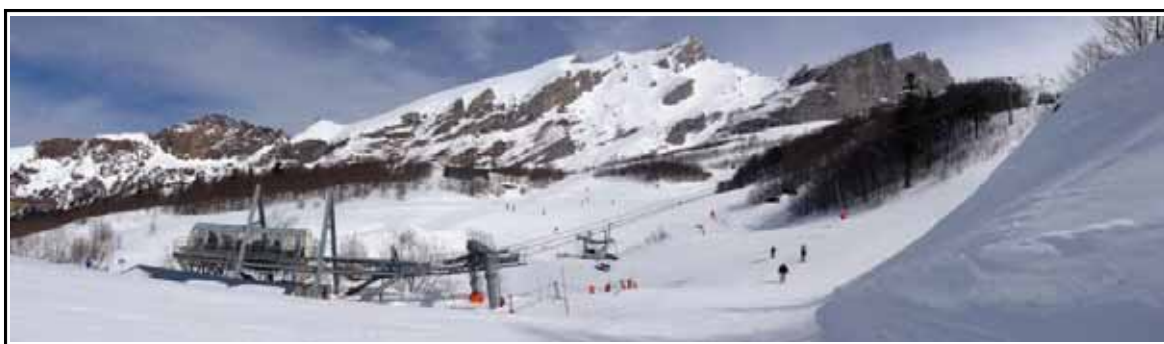
Fig. 4 : Vue de la station basse et du début de la ligne du télésiège « Fontaines-de-Cotch »
