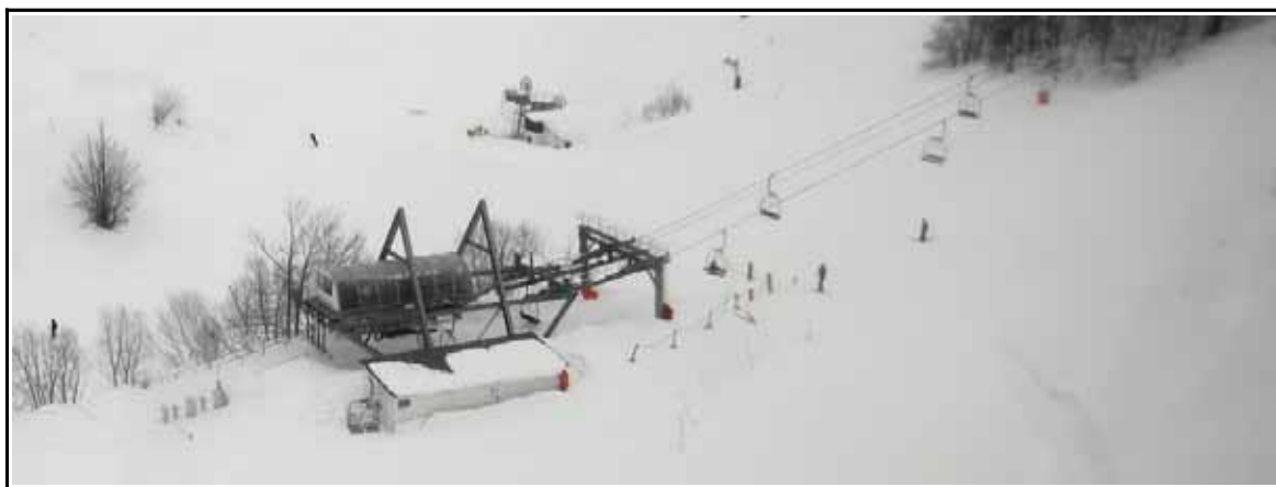
Fig. 1 : Vue de la station basse du télésiège « Fontaines-de-Cotch »
