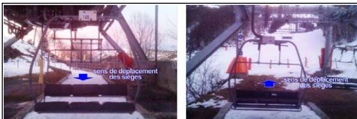
Fig. 8 : Vues de la zone d'embarquement le jour de l'accident
