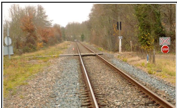
Figure 22 : Vue du passage à niveau n° 64, dans le sens de circulation d'un train se dirigeant vers Paray-le-Monial
