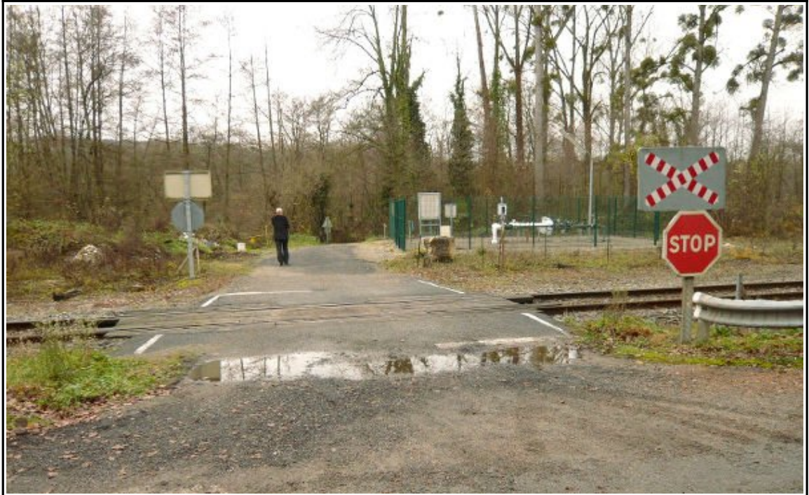
Figure 13 : Vue du passage à niveau n° 65 depuis l'ancienne route départementale
