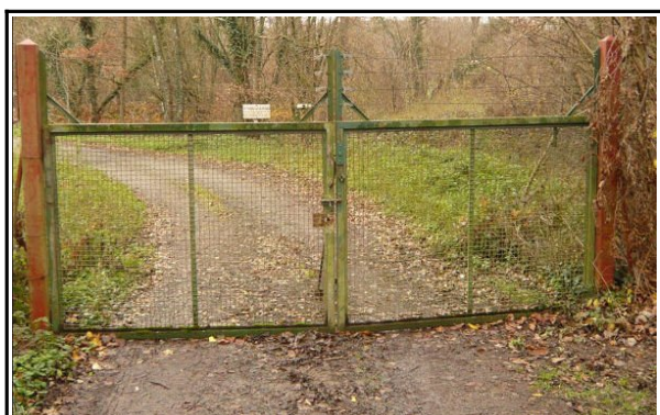
Figure 7 : Vue du portail situé à l'extrémité du chemin communal
