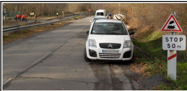
Figure 36 : Vue n° 5, l'ancienne route départementale à proximité du passage à niveau n° 65
