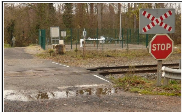
Figure 5 : Vue du poste de gaz implanté à droite, après le passage à niveau, en venant de l'ancienne route départementale
