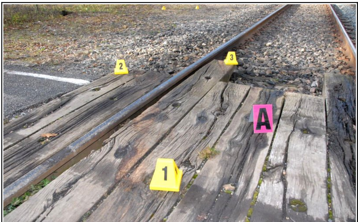
Figure 25 : Vue, dans le sens de circulation du train impliqué, des traces laissées par l'automobile sur le platelage du passage à niveau, avec sous la référence « 1 » celle du ripage de la roue arrière-droite
