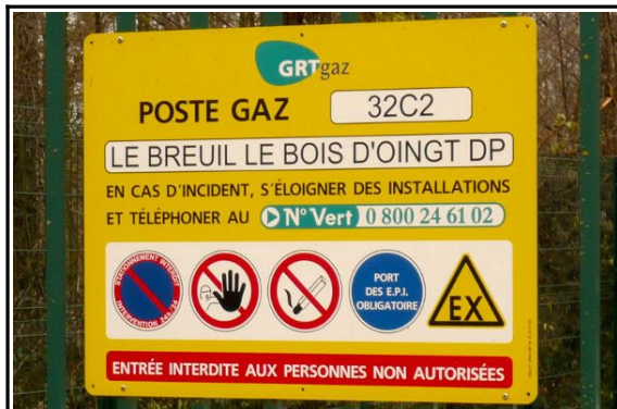
Figure 6 : Vue du panneau d'identification du poste de gaz
