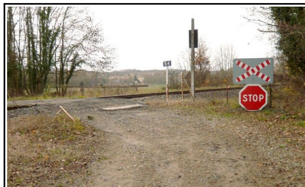
Figure 23 : Vue du passage à niveau n° 64, de la RD 385 vers les champs
