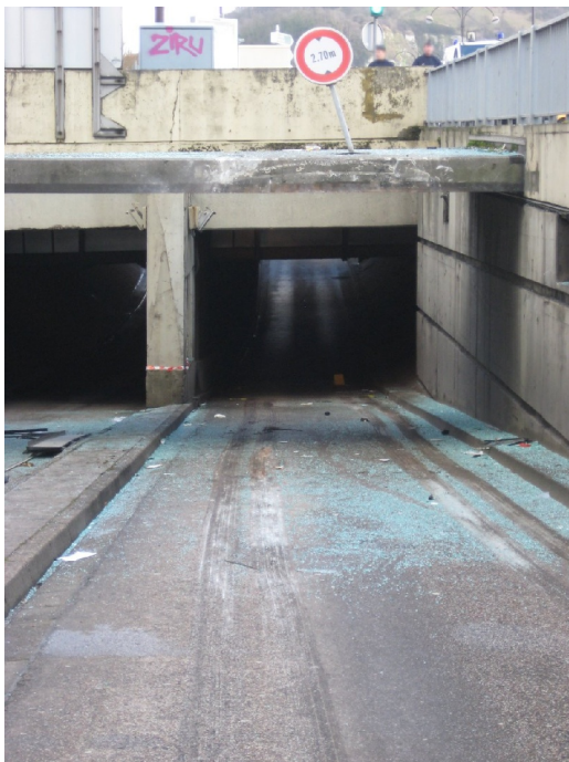
L'entrée de la trémie après l'accident
