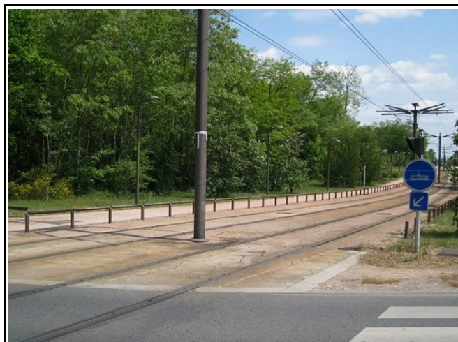
Fig. 2 : Position du poteau support de LAC
