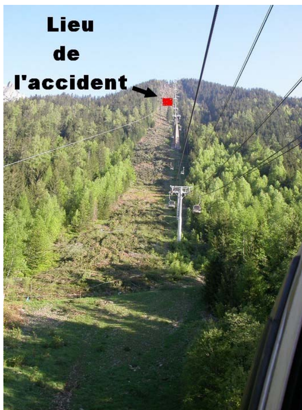
Photo 3 : Lieu de l'accident vu d'une cabine montante
