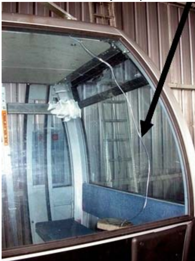
Photo 6 : Fêlure du vitrage d'une cabine « OMEGA » III 6 légère sous un effort « dynamique »
