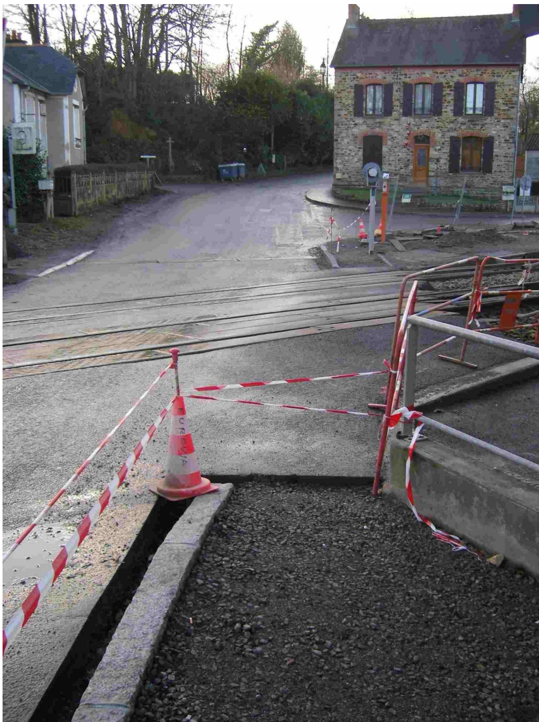
Photo 7 : Les travaux à l'origine de l'alternat temporaire.
