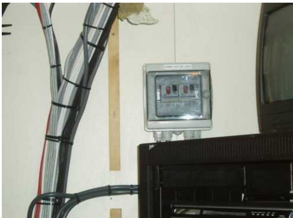
Boîtier de démarrage des pompes d'assèchement compartiment situé à la réception
