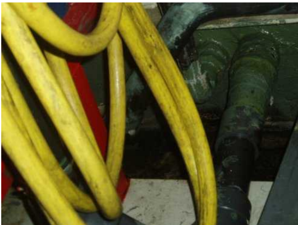
Passage de cloison étanche des tuyautages sanitaires étanchés à la résine époxy lors des réparations
