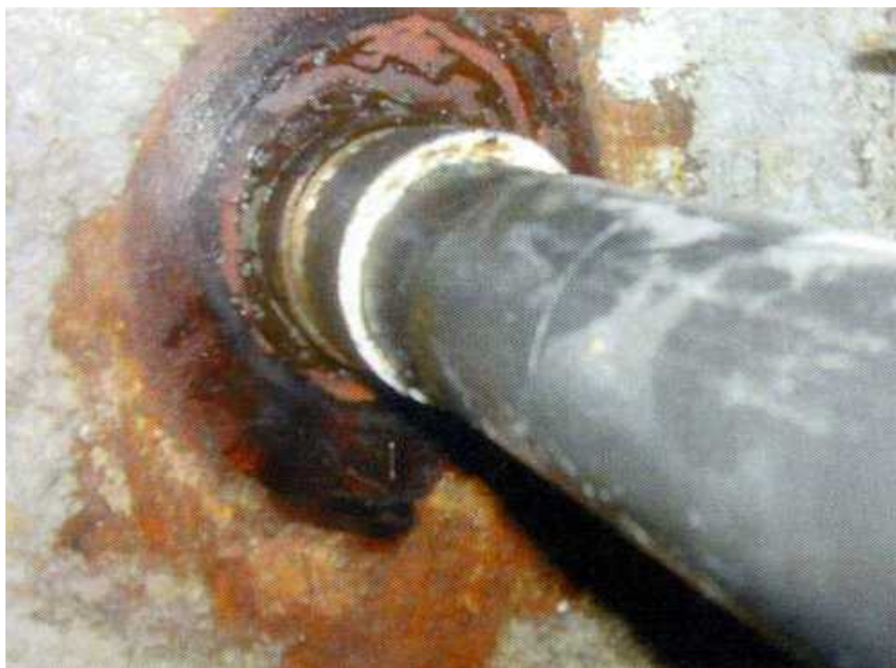
Etanchéité réalisée autour des tuyaux pour le passage de cloison étanche
