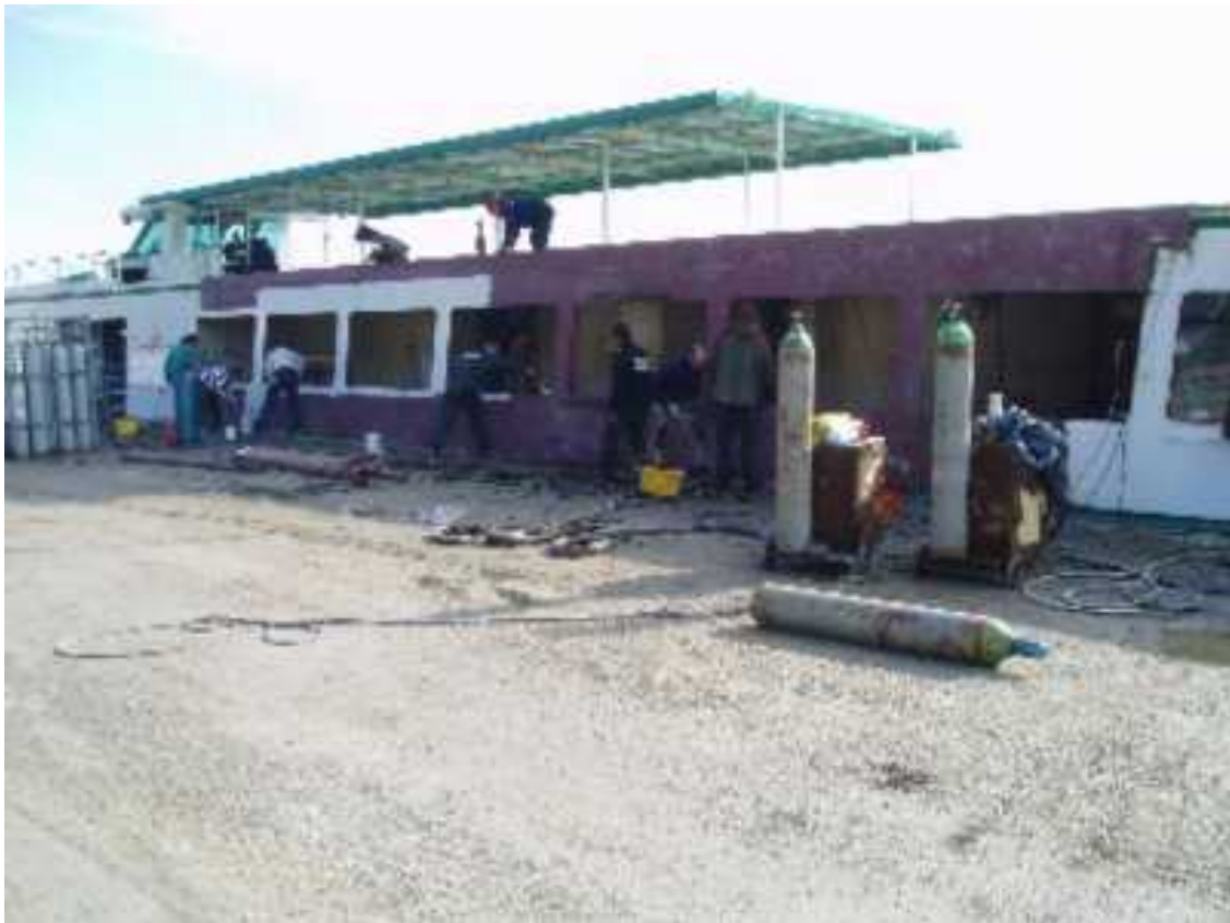
Réparations en cours après l'accident
